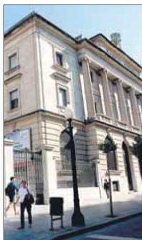
L'edifici del Banc d'Espanya de Tarragona té uns 2.400 m 2 de superfície ■ ARXIU
