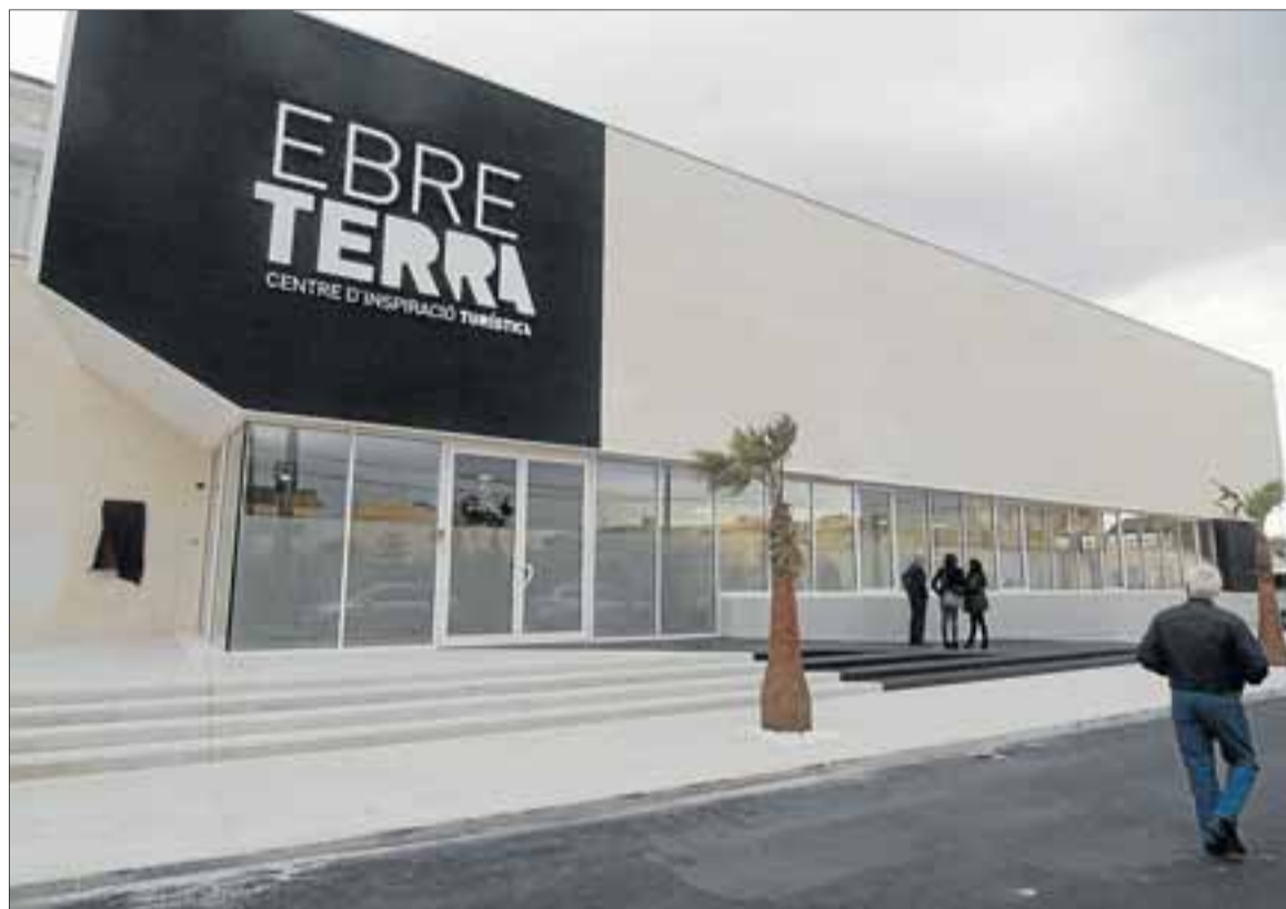
Façana del centre EbreTerra, al municipi de Deltebre. FOTO: JOAN REVILLAS
